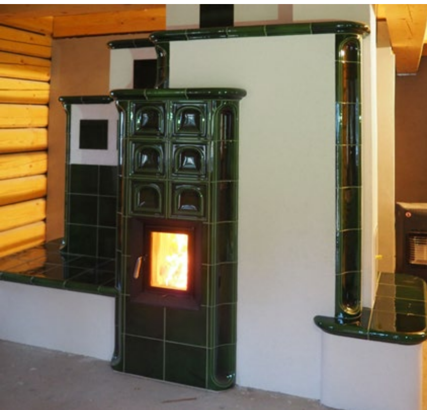
Kamnová vložka Brunner HKD 6.1 s tahovým systémem v kachlové obestavbě doplněné omítkou, realizace: roubenka Český Jiřetín
