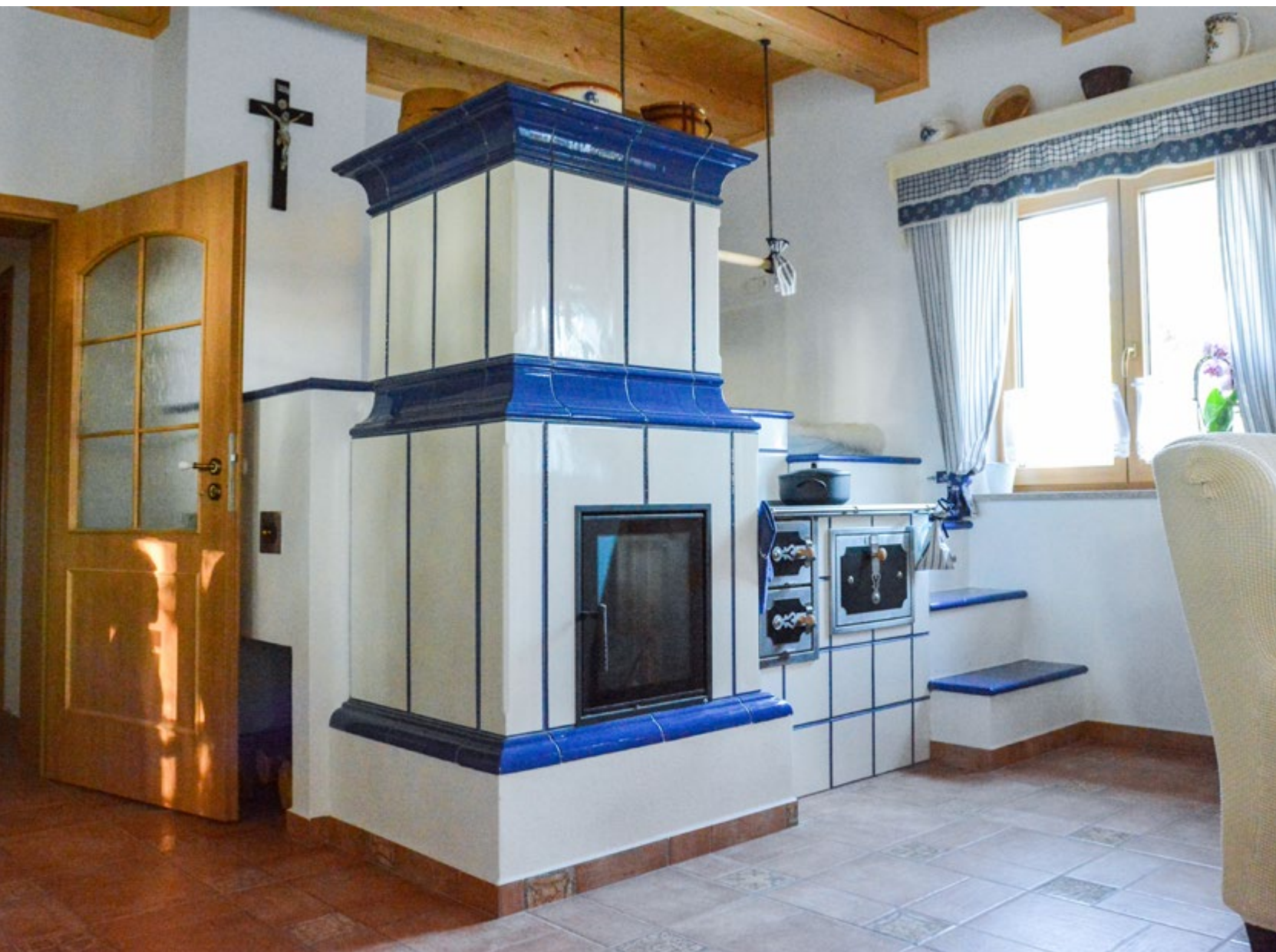
Kachlová kamna a nesmrtelná modro-bílá kombinace barev. Srdce kamen tvoří kamnová vložka Spartherm Nova , sporákové kování od firmy Řehulka. Kachle s modrou fazetou a římsami Robust vyrobilo Kamnářství Bechyně. Realizace David Vosecký
