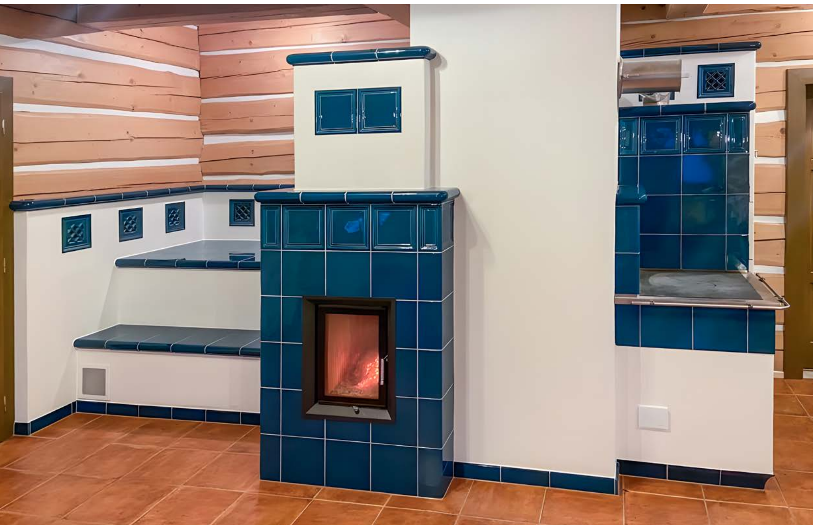
Kamna v roubence - šamotové biotopeniště, tahy KMS, regulace Timpex, kachle Hein, stavba v roubence, hypokaustem vytápěná vedlejší místnost, v horním patře hypokaustem vytápěny dva pokoje a chodba. Založeno na dřevěném stropě. Sporák kování JOKR
