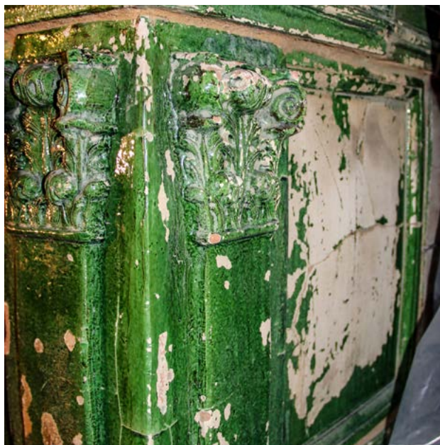
Narušení soudržnosti střepu a glazury ve vlhkém prostředí. Glazura se uvolňuje od keramického podkladu a tvoří puchýřky, při dalším působení vlhkosti samovolně odpadá.
