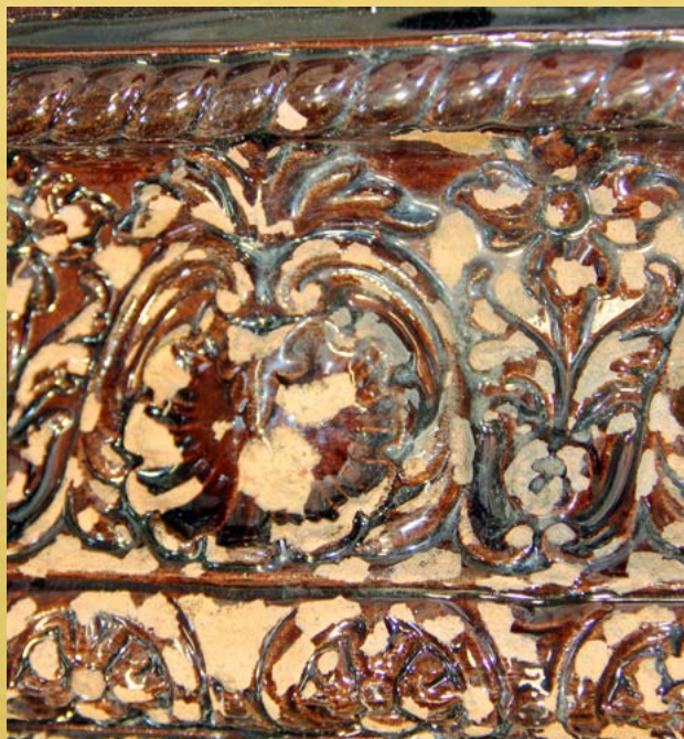
Obr. č. 5. Kachle byly vystaveny extrémním podmínkám působení deště a mrazu, a proto došlo k narušení keramického střepe a opadání glazury.
