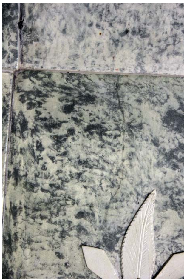
Obr. č. 1. Prasklý kachel v okolí topeniště – prasklina pravděpodobně vznikla vlivem používání kamen (v důsledku dilatace kachlů).
