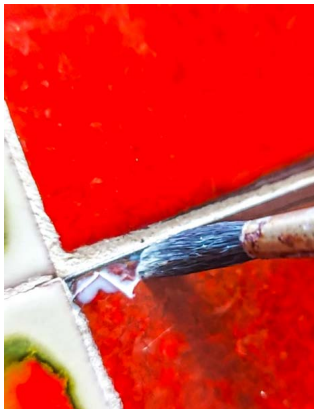
Zpevnění – petrifikace uvolněné glazury nátěrem
