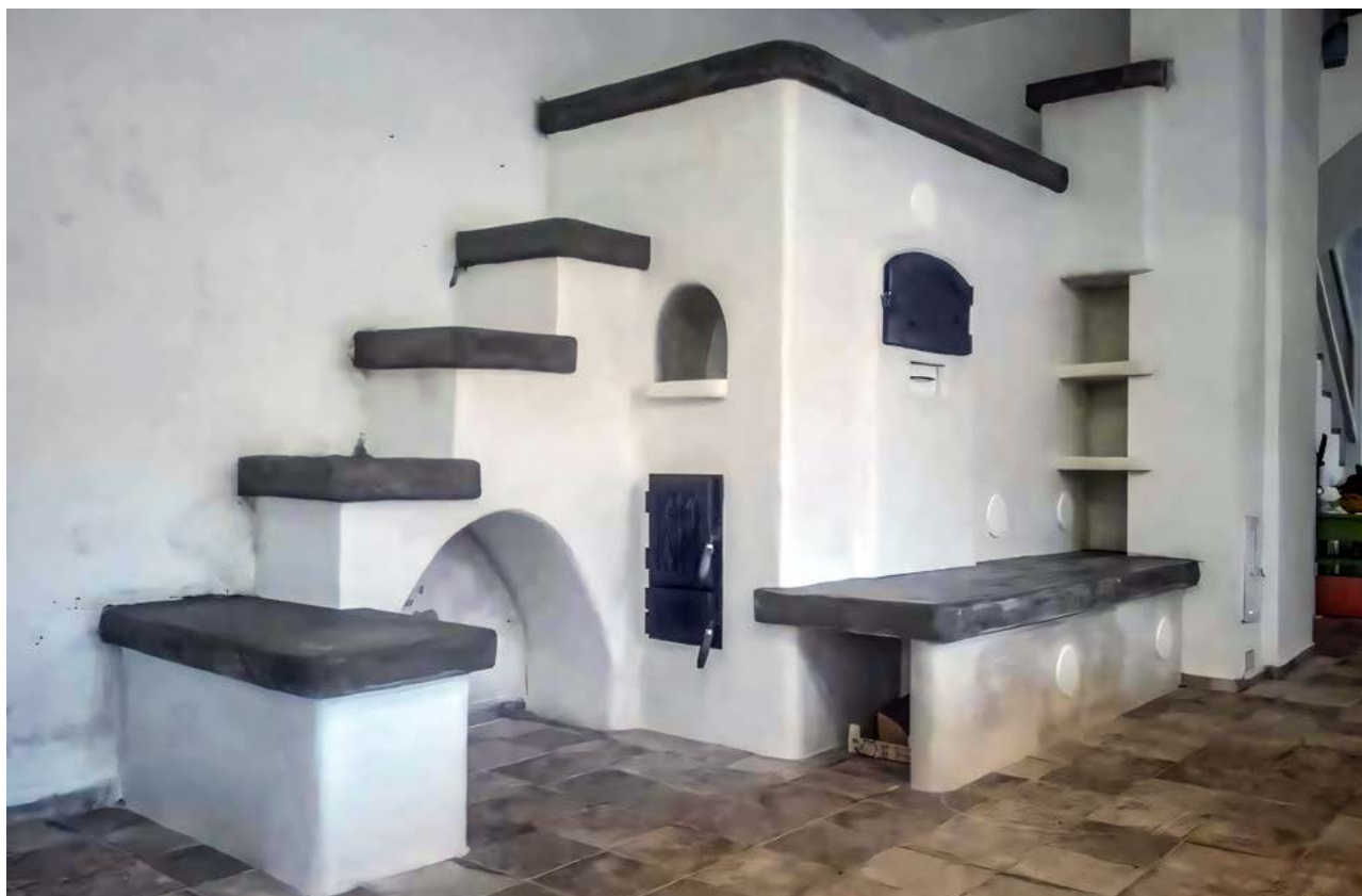
Zakázková stavba akumulčních kamen s integrovanou šamotovou pecí, vyhřívanou lavicí, ležením a plotýnkou na temperování čaje
